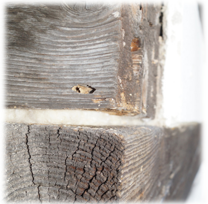
Von aussen verschlossener Zugang in die Zwischenwand eines Fachwerkhäuses.
