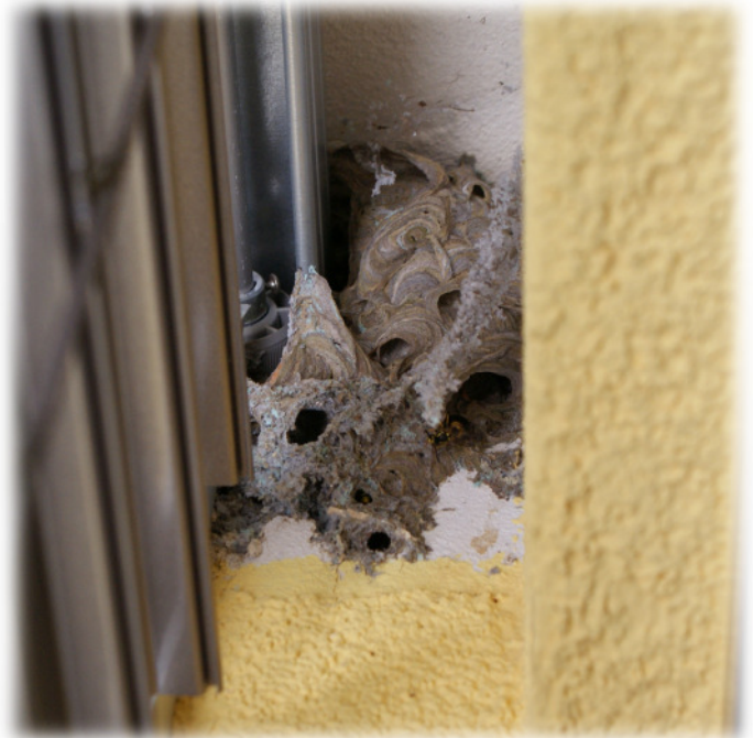
In der Storennische und Aussenisolation eines Neubaus.
