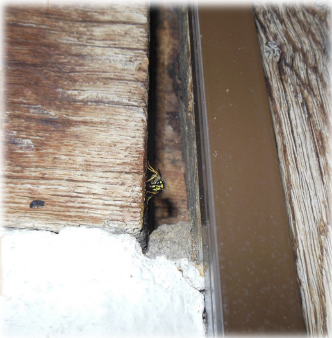
In der Zwischenwand eines Fachwerkhäuses.
